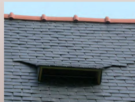
Ouverture pour les chauves-souris dans une toiture
